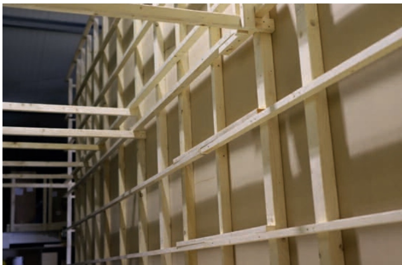
Die rückseitige Verstrebung und sichernde Stützverbindung zur Hallenwand
